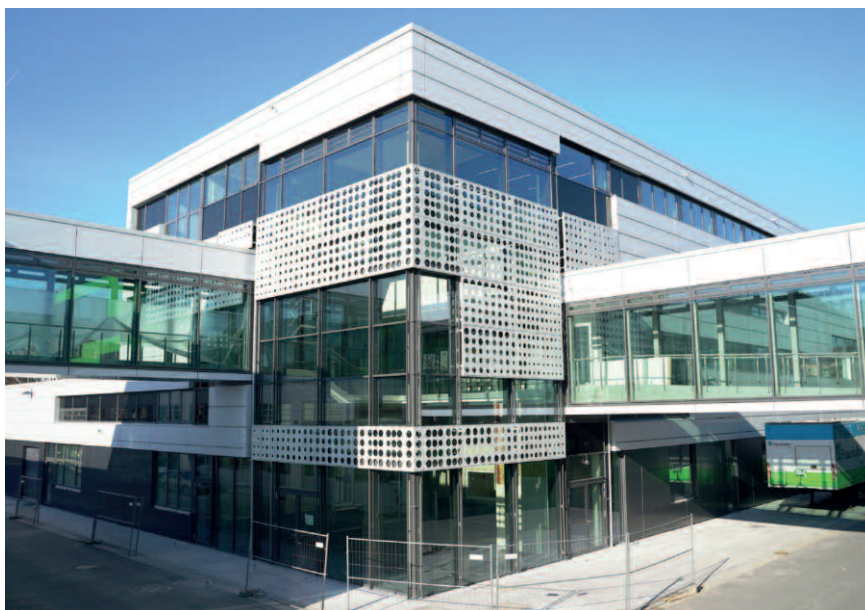
Neubau des Labor- und Technikumsgebäudes des Fraunhofer FEP an dessen Südbrücke (rechts) die Nachrüstlösungen des Projektes integriert werden (© Fraunhofer FEP, Fotograf: Finn Hoyer)
